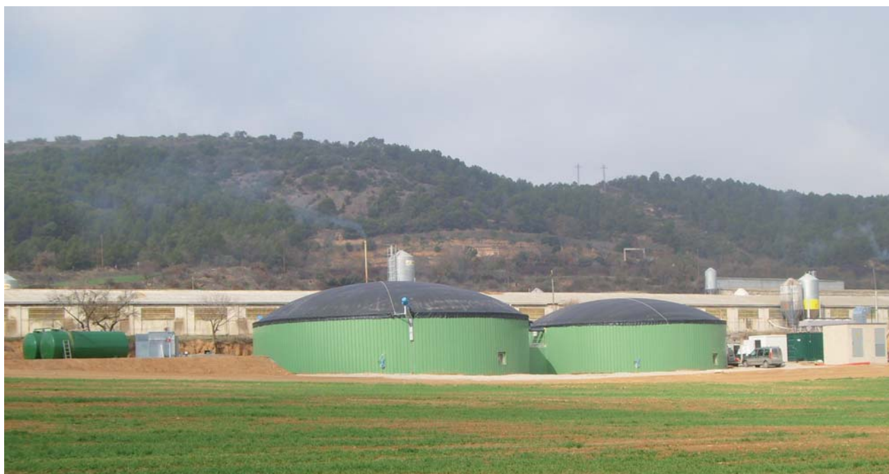
Titular de la planta: Agrícola Montargull. Ingeniería: ECOBIOGAS
