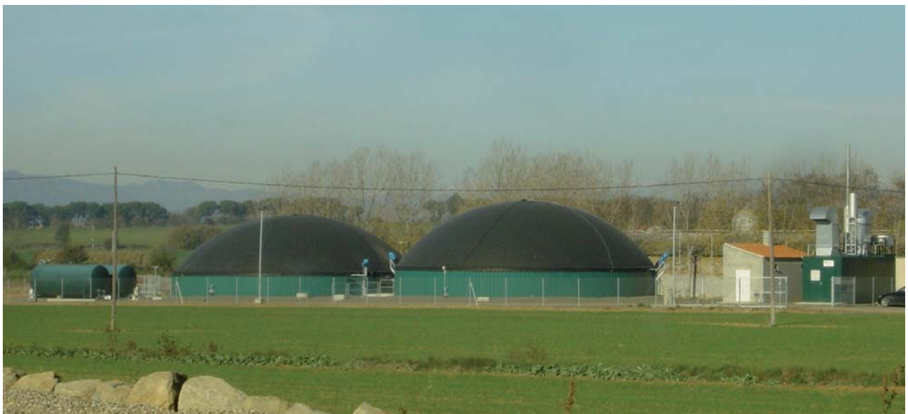
Titular de la planta: SAT Moliné. Ingenierías: ECOBIOGAS
