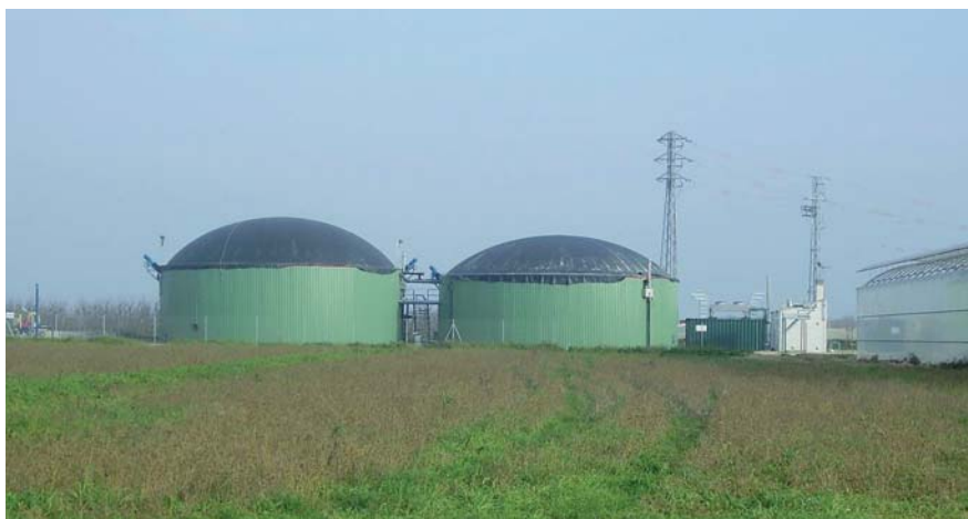
Titular de la planta: Porgaporcs. Ingeniería: ECOBIOGAS
