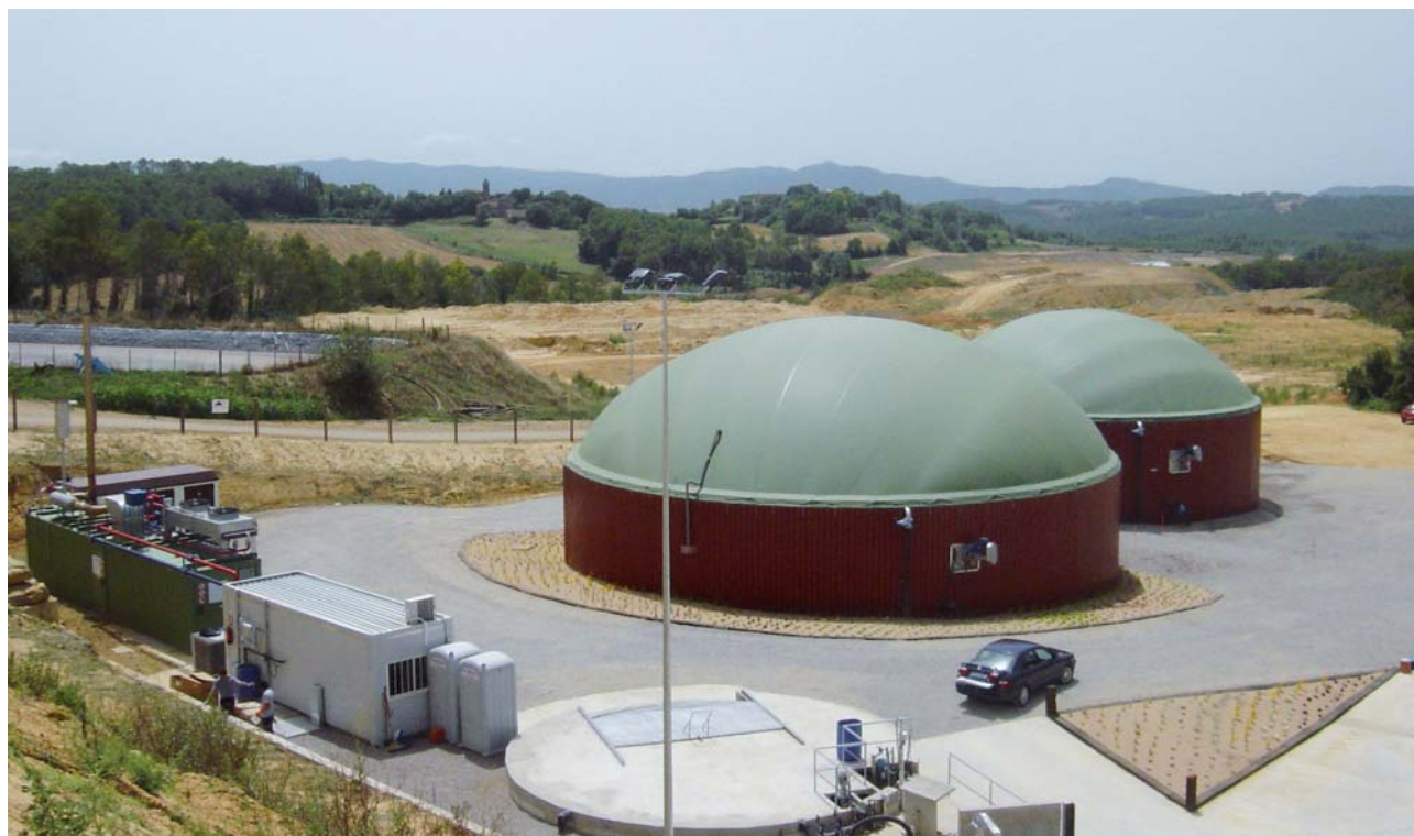
Titular de la planta: SAT Sant Mer. Ingenierías: ENERGI Y BIOVEC
