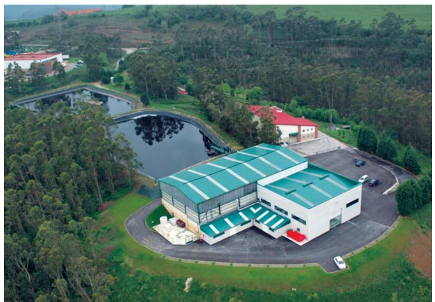
Figura 3. Vista general de la Planta de Tratamiento de Lixiviados
