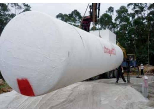
Figura 8. Instalación del depósito de metanol soterrado.
