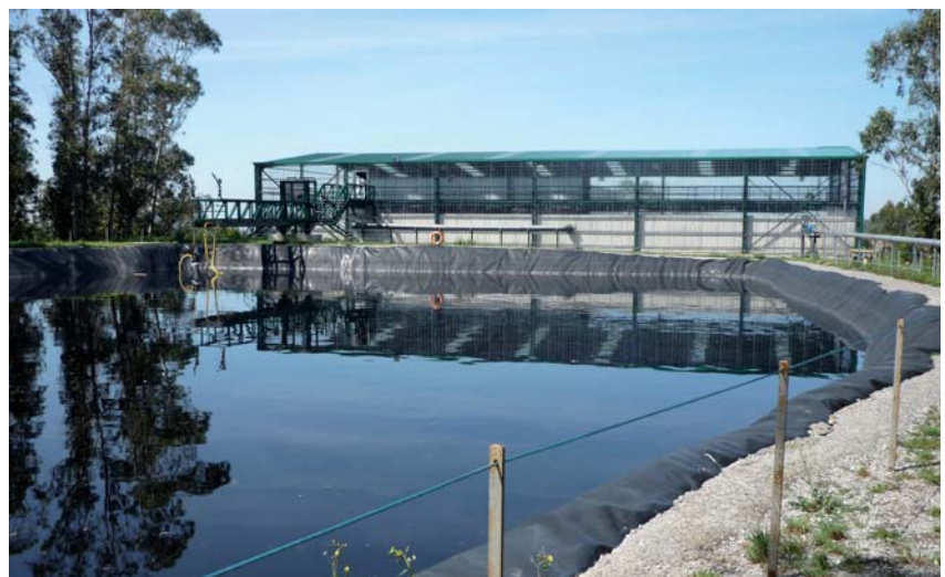
Figura 2. Balsa de almacenamiento de lixiviados
